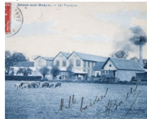
La papeterie au début du XX e siècle avec les extensions réalisées entre 1895 et 1906 : grands ateliers de couchage et salle de triage en pan-de-fer couverte de sheds 3, les logements ouvriers de la papeterie conservés, bien que remaniés dans les années 1950, face à l'usine 4.
