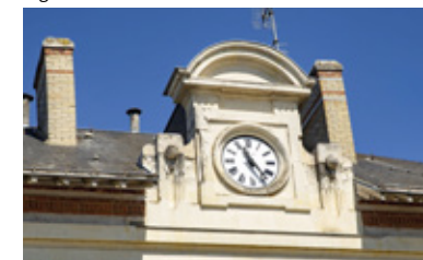
Détail de la lucarne et de l'horloge du logement des institutrices.
