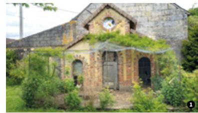
Ancien chenil du château de la Gavalerie, XIX e siècle ❶. Vue avant travaux de la charpente à petits bois du logis. ©Isabelle Martin ❷.
