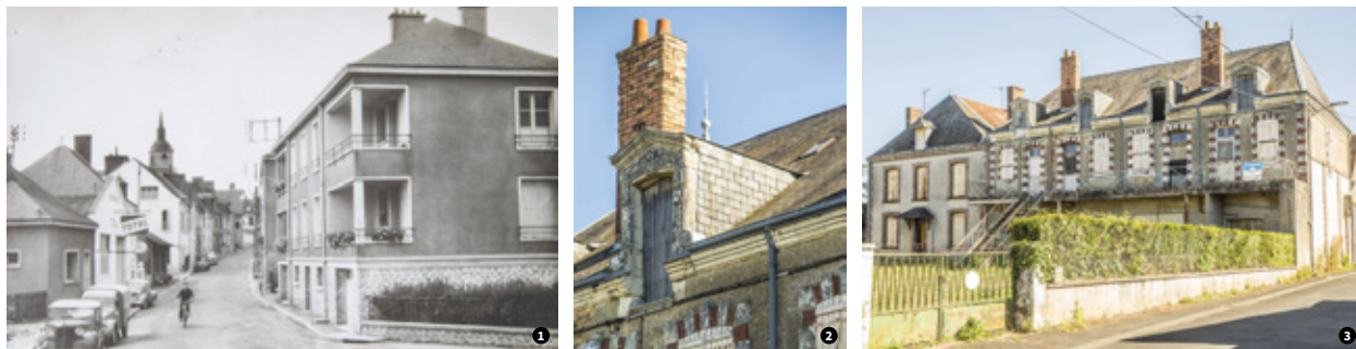
Immeuble de la Reconstruction (vers 1950), rue du Docteur Ferrien ❶. Anciens Tissage Besnard, détail d'une lucarne en pierre de taille, 3 impasse Gambetta ❷. Vestiges des anciens Tissage Besnard, transformés après 1889 en logements, 3 impasse Gambetta ❸.
