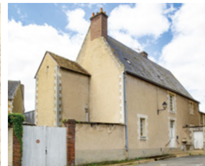
Le presbytère avec son pignon fin XV e - début XVI e siècle et sa façade côté place de la Tour, remaniée dans le dernier quart du XIX e siècle.
