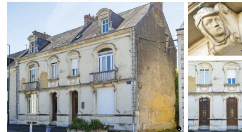
Maison de l'entrepreneur Debourges-Mary construite en 1906, 61-63 avenue Jean-Jaurès : vue générale de la façade ❶, détail sculpté d'un support de balcon ❷, travées centrales ❸.
