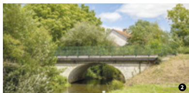
Le pont Rouge sur la Braye ❶. Le pont Blanc sur un bras secondaire de la Braye ❷.
