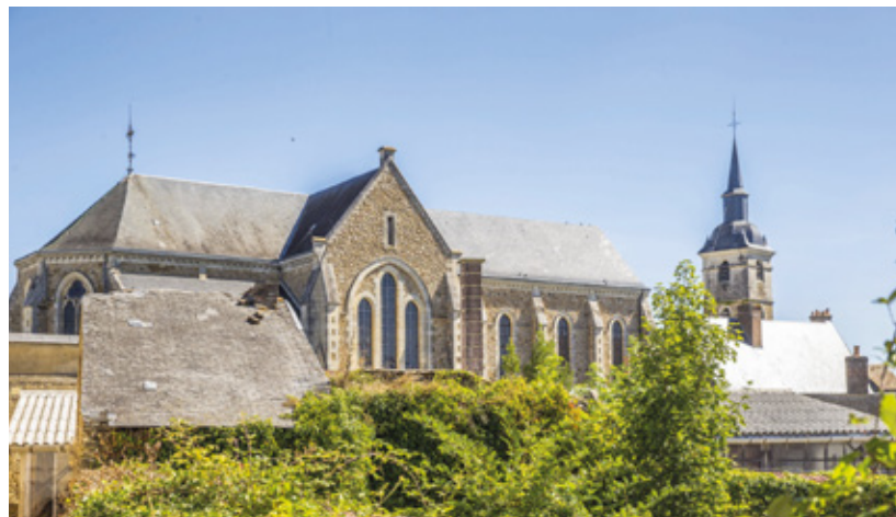
L'église actuelle construite entre 1891 et 1893 et l'ancienne tour clocher.
