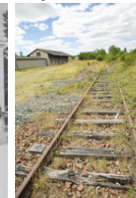
La voie de chemin de fer désormais aménagée en voie verte.
