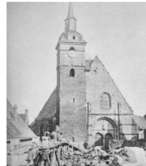
L'église Notre-Dame-de-l'Assomption avant sa démolition en 1895.
