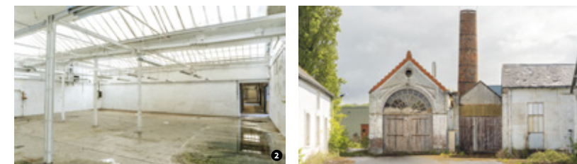
Ancien Tissage Leroux de La Roche : le site à la sortie du bourg en direction de Bonneveau, au début du XX e siècle ❶, vue des vestiges des ateliers à charpente métallique couverte de sheds et de la chaufferie construits entre 1872 et 1875 ❷ et ❸.
