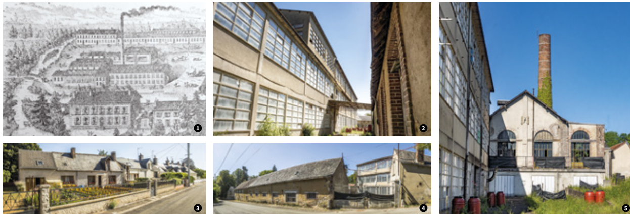
1 à 5 La filature (rue Élie Savatier) : vue de l'usine édifée vers 1860 (Archives départementales de la Sarthe, 18J759) 1, le nouvel atelier construit vers 1950 (à gauche) 2, anciens logements ouvriers 3, la chaufferie et la salle des machines édifées vers 1860 4.
